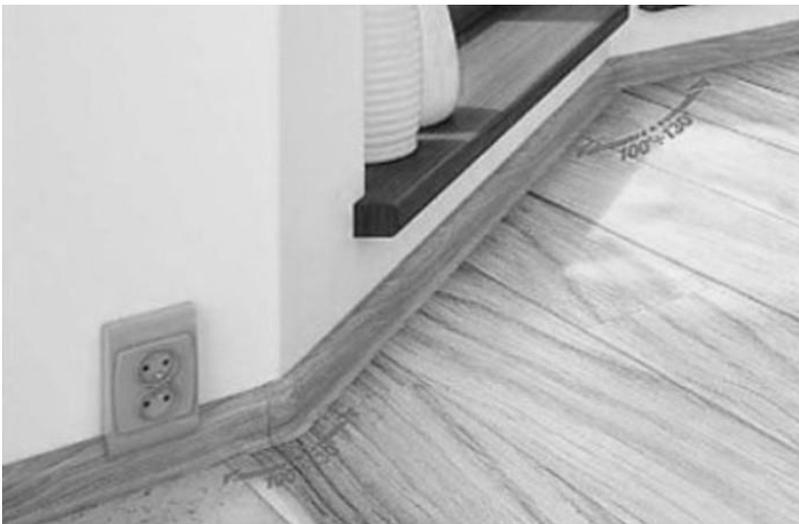
Фурнитура для плинтуса устанавливается без саморезов. Упругими уголками можно аккуратно соединять плинтусные планки в любых внутренних и наружных углах стен, в том числе, в углах отличных от прямых.
